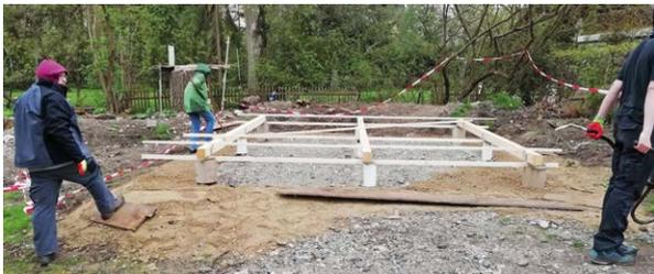
Zuerst musste der Platz jedoch geräumt und eingeebnet werden, das machte uns Peter mit seinem Kleinbagger. Dann entstanden die Fundamente, die Stelzen, die Bodenplatte, das Balkenwerk und das Rohdach, die einzelnen Wände und deren Verschalung sowie das Profilblechdach. Zuletzt wurden Fenster und Tür eingebaut und das Laminat verlegt.
